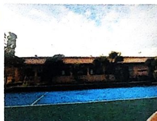
โรงอาหาร - หอประชุม (กค.), 100/32, ประเภทสิ่งก่อสร้าง โรงอาหาร/หอประชุม อายุการใช้งาน 41 ปี สภาพการใช้งาน พอใช้ ปี พ.ศ. ที่ก่อสร้าง 2526 งบประมาณ 648,500 บาท
