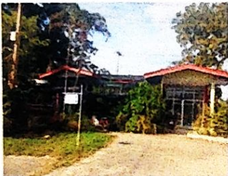
อื่น ๆ (สร้างเอง) ประเภทสิ่งก่อสร้าง อาคารนอกประสงค์ อายุการใช้งาน 24 ปี สภาพการใช้งาน ดี ปี พ.ศ. ที่ก่อสร้าง 2543 งบประมาณ 80,000 บาท
