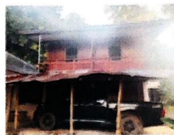
บ้านพักการโรง/32 ประเภทสิ่งก่อสร้าง บ้านพักการโรง อายุการใช้งาน 30 ปี
