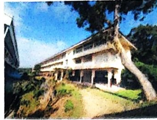
อาคารเรียน 212 ค /57-ข (ในเขตแผนดินไหว) ประเภทสิ่งก่อสร้าง อาคารเรียน อายุการใช้งาน 10 ปี ห้องคาบเรียน 12 ห้อง ห้องจริง 16 ห้อง ต่อเติมห้อง ห้อง สภาพการใช้งาน ดี ปี พ.ศ. ที่ก่อสร้าง 2557 งบประมาณ 21,220,000 บาท
