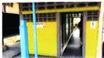
สถานอาคาร 6 ปีบึง / 27 ประเภทสิ่งก่อสร้าง ห้องน้ำประปา
