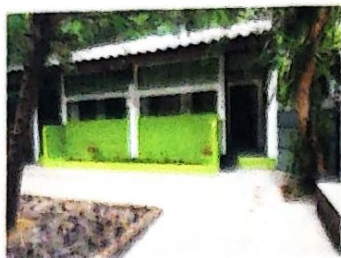
สถานอาคาร 6 ปีบึง / 27 ประเภทสิ่งก่อสร้าง ห้องน้ำประปา อายุการใช้งาน 33 ปี
