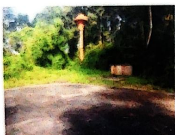
หอคนน้ำ(ประปา ร.ร.) ประเภทสิ่งก่อสร้าง หอน้ำ อายุการใช้งาน 30 ปี
